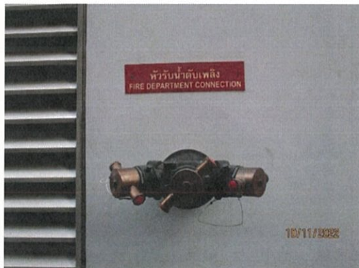
รูปที่ 2-34 หัวรับน้ำดับเพลิงภายนอกอาคาร
