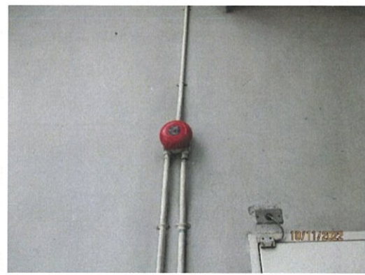
รูปที่ 2-40 กริ่งสัญญาณเตือนภัย (Alarm Bell)
