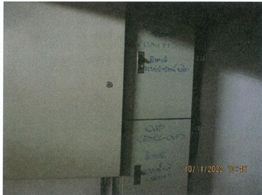
รูปที่ 2-10 มิเตอร์ไฟฟ้าสำหรับระบบบำบัดน้ำเสียของโครงการ โดยเฉพาะแยกจากระบบไฟฟ้าอื่นๆ
