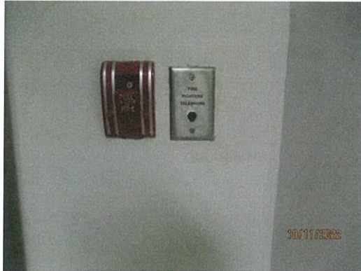
รูปที่ 2-41 เครื่องแจ้งเหตุโดยใช้มือดึง (Fire Alarm Manual Station)
