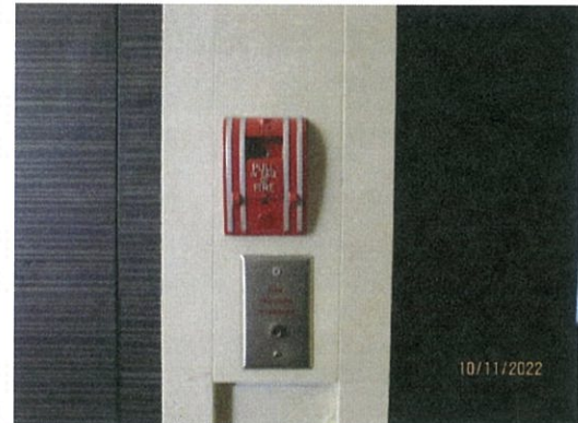
รูปที่ 2-41 เครื่องแจ้งเหตุโดยใช้มือดึง (Fire Alarm Manual Station)
