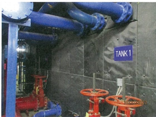
รูปที่ 2-12 ถังเก็บน้ำชั้น 8 จำนวน 2 ถัง
