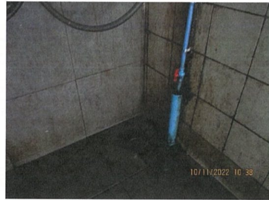
รูปที่ 2-22 ท่อรวบรวมน้ำจากการล้างห้องพักมูลฝอย
