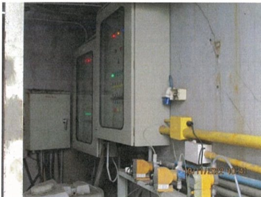
รูปที่ 2-7 แผงควบคุมระบบบำบัดน้ำเสียวน
