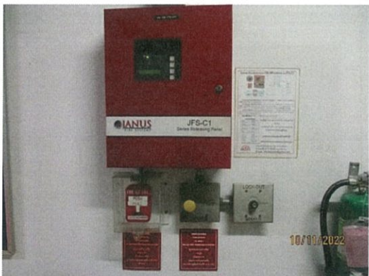
รูปที่ 2-38 ระบบเตือนภัย Fire Alarm Control Panel : FCP
