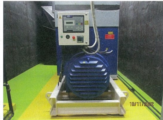
รูปที่ 2-26 ระบบไฟฟ้าสำรอง
