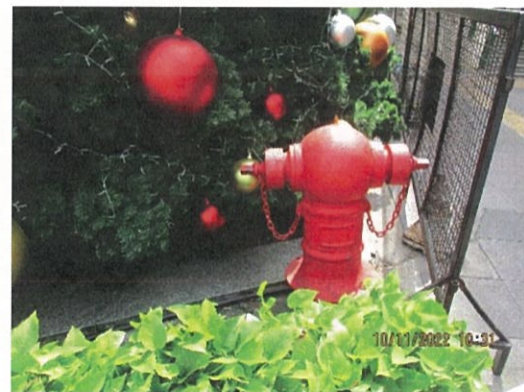
รูปที่ 2-34 หัวรับน้ำดับเพลิงภายนอกอาคาร
